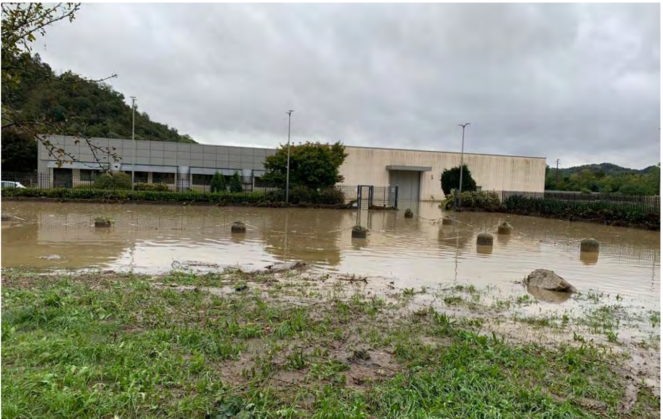
Le alluvioni costituiscono uno dei principali di rischio per le imprese della gomma. Floodings are among the main risk scenarios for rubber companies. Foto Belfor.
